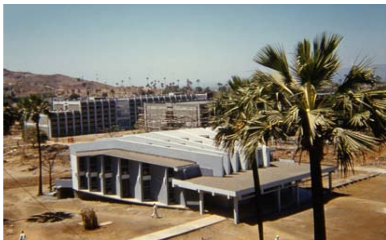
Іл. 7. Будівництво кампуса ІІТ Бомбея в Поваї
