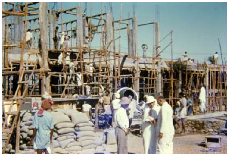
Іл. 5. Проф. Шішір Кумар Босе, перший директор ІІТ Бомбея (праворуч), контролює заливання плити перекриття першого поверху корпусу інституту
