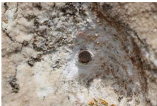
Рис. 10. Залишки металевого кріплення в правому нижньому куті мармурової плити. Фото автора
