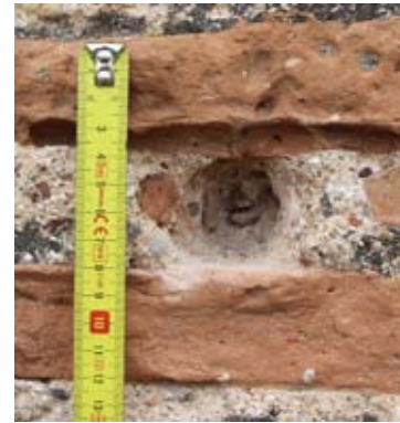
Рис. 13. Залишки металевої основи кріплення у верхньому отворі, над рамковим обрамленням мармурової плити. Фото автора
