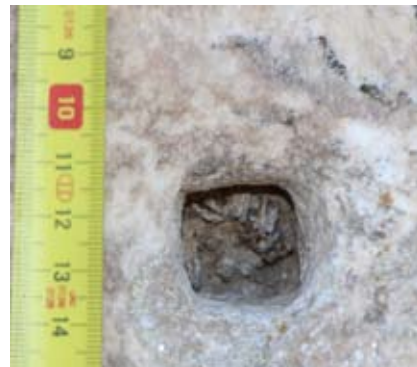
Рис. 9. Отвір у центральній частині плити із залишками свинцевої заливки всередині. Фото автора
