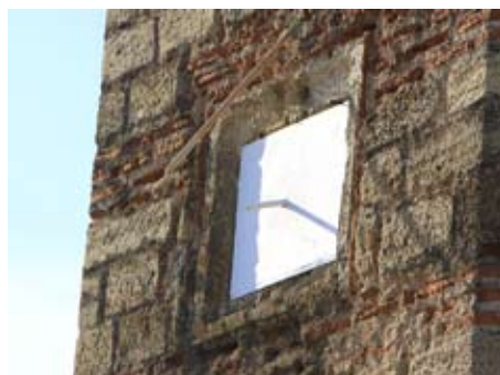
Рис. 22. Реконструкція сонячного годинника на фасаді вежі № 11 з накладеним фанерним макетом на мармуровий кадан. Аср, 15.11 за зимовим часом, 1 березня 2023 р. Фото автора
