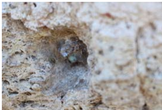
Рис. 11. Залишки бронзової трубки в нижньому західному отворі рамкового обрамлення мармурової плити. Фото автора
