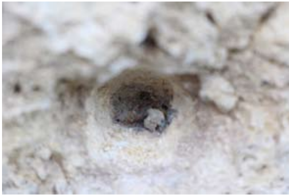
Рис. 12. Залишки металевої основи кріплення в нижньому східному отворі рамкового обрамлення мармурової плити. Фото автора
