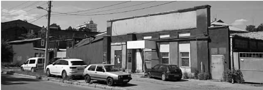
Іл. 12. Будівлі Другої (Міщанської) синагоги. Фото В. М. Ряполова, 2019 р.
