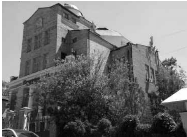
Іл. 14. Будівля головного корпусу Третьої (Мордвиновської) синагоги, вигляд з північного заходу. Фото В. М. Ряполова, 2019 р.
