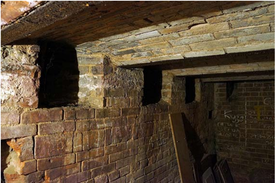
Іл. 53. Квадратні вікна повітропроводу в підвальній радіаторній кімнаті особняка Д. О. Алчевського в Харкові. Сучасне фото В. М. Ряполова
