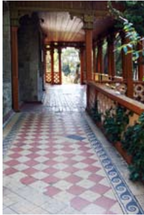
Іл. 19. Вид з північного заходу на відкриту терасу та айван садибного будинку дачі О. М. Бекетова в Алушті. Сучасне фото В. М. Ряполова
