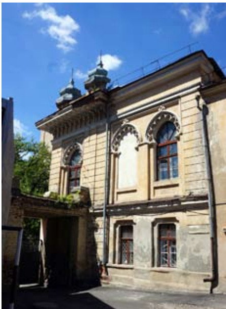
Іл. 45. Ліве крило південно-східного фасаду особняка Д. О. Алчевського в м. Харкові, вигляд зі сходу. Сучасне фото В. М. Ряполова
