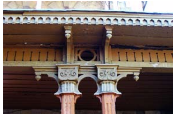
Іл. 22. Фрагмент здвоєних колон, прорізного фризу та карниза айвана садибного будинку дачі О. М. Бекетова в Алушті. Сучасне фото В. М. Ряполова
