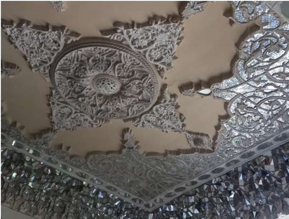
Іл. 6. Дзеркальні сталактити та мозаїки, а також візерунки з пластичним декором з алебастру штибу стукко (штучного мармуру) у приміщенні зали за анфіладою Тбіліської академії мистецтв імені Аполлона Кутателадзе після реставрації 2010-х рр.
